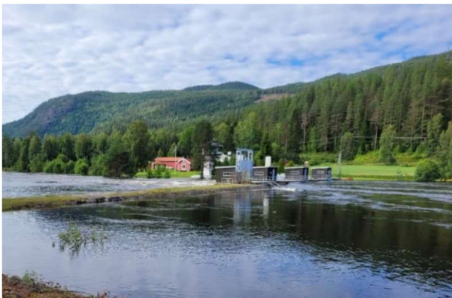
Sperillen dam. 11. august. Flom. Foto: Øyvind Eidsgård
