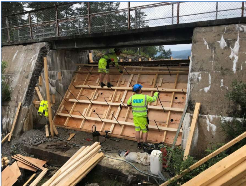
Samsjøen. 20. juni. Påstøp vestre dam. Foto: Øyvind Eidsgård
